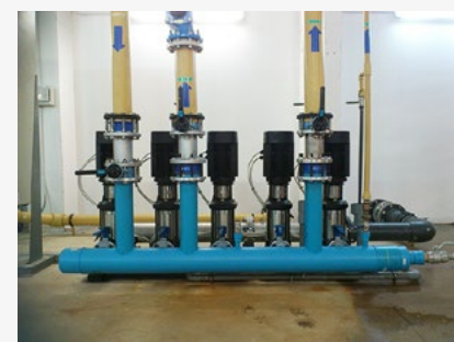
Sustitución por colector nuevo en PP-R. Inmune a la corrosión.
